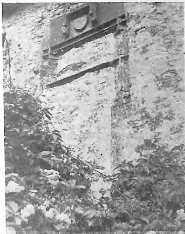
Fenêtre gothique de bourg
