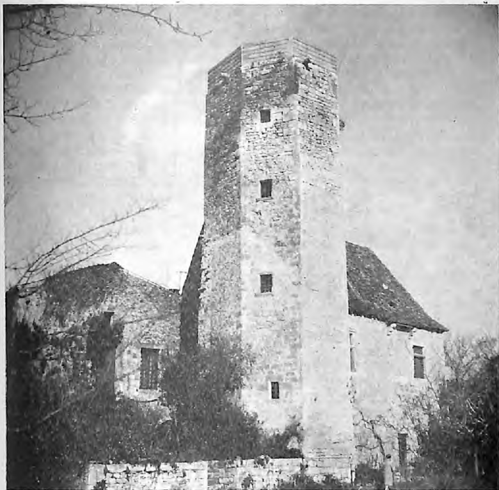
Château de La Rue, vue du Sud.
