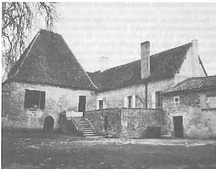
Entrée sud donnant sur la cour
