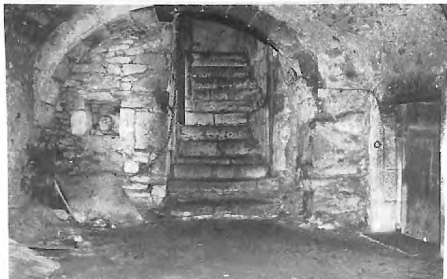
Cave n° 2, au pied de l'escalier. A droite, la porte donnant dans la cave n° 3.
