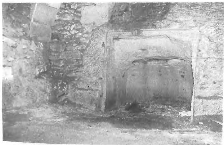
Cave n° 2. L'alcove (sous la rue du Plantier) et le départ du jour de souffrance.
