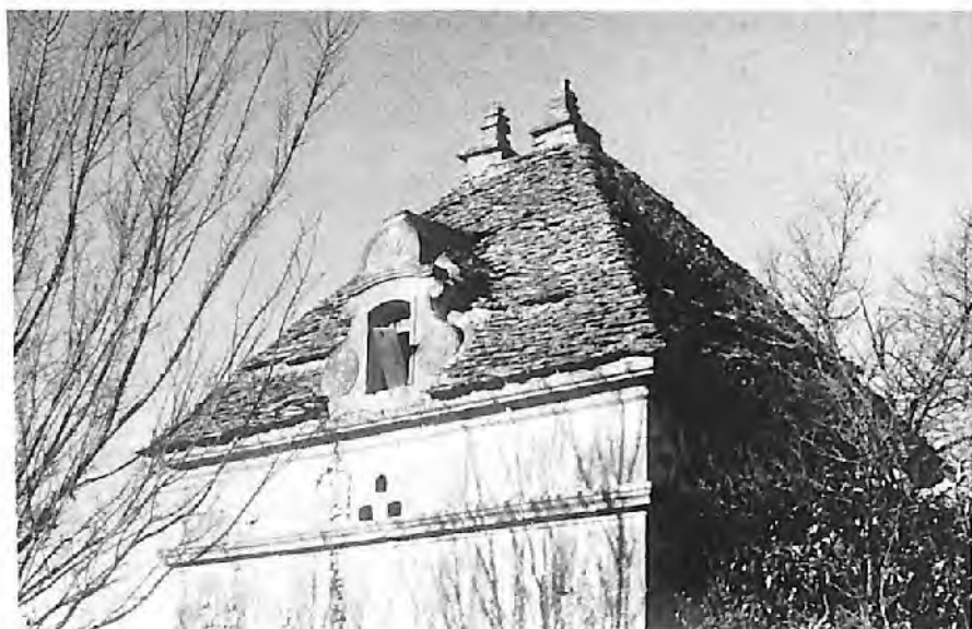
Pigeonnier présentant une fort belle toiture.
