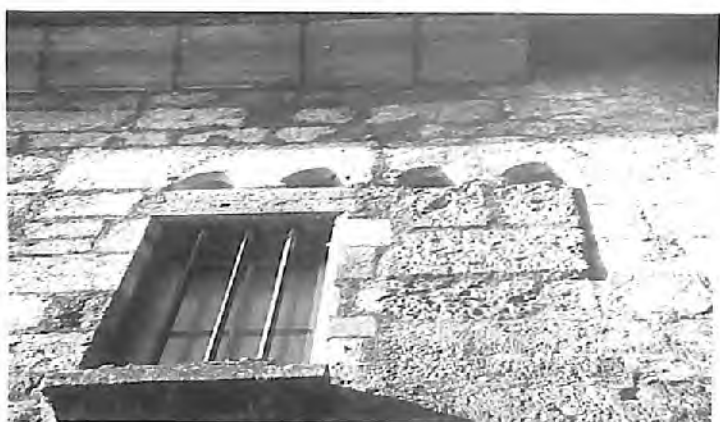
Fig. 14 : Périgueux, maison 18, rue du Plantier. Fenêtre à quatre baies, couvertes par deux linteaux ; les arêtes sont chanfreinées.
