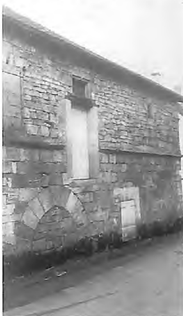
Fig. 36 : Saint-Amand-de-Coly, maison du XIII e siècle, face à l'entrée occidentale de l'enclos abbatial. Façade sur rue avec arcades murées et vestiges de fenêtres au-dessus du cordon, aux deux extrémités de la façade.
