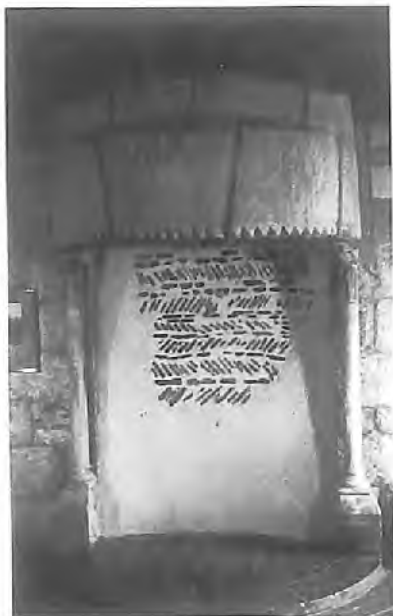
Fig. 30 : Coulounieix, maisons du XIIe siècle, dites «hôpital Charroux». Hotte de la cheminée de la maison centrale ; de forme conique, elle repose sur des colonnettes.
