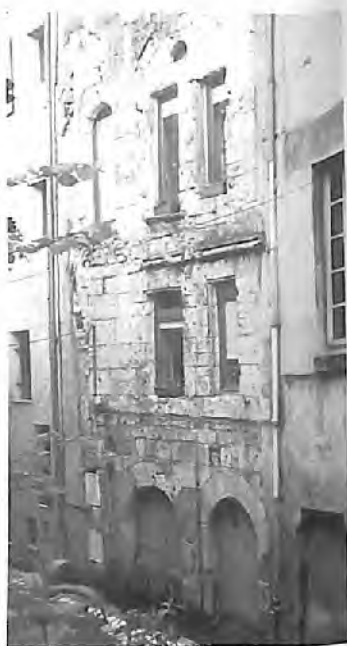
Fig. 15 : Périgueux, maison 12, rue du Port-de-Graule. Façade sur la rue ; haute et étroite maison dont le rez-de-chaussée, ouvert de deux arcades, devait comporter un entresol (il est aujourd'hui recoupé par un plancher) ; au-dessus du cordon d'arase, grande fenêtre dont on aperçoit l'oculus sous un arc qui correspond à l'arrière-voussure.
