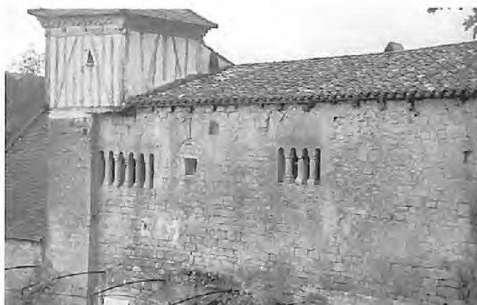
Fig. 24 : Bigaroque, maison du XIIe siècle, près de l'église. Détail de l'étage ; deux fenêtres de quatre à six baies encadrent une porte qui paraît être l'unique accès au logis ; la mutilation des arcs au-dessus des fenêtres prouve que le bâtiment a été arasé.
