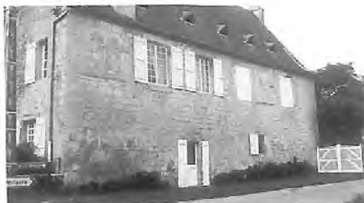
Fig. 39 : Trémolat, maison du XIII e siècle, dite «la Barrière». Façade nord ; les percements sont rares au rez-de-chaussée ; trois fenêtres géminées à l'étage.
