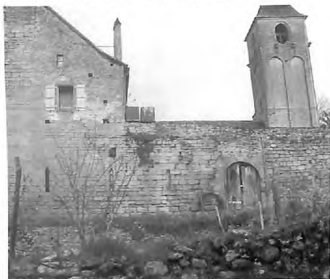
Fig. 35 : Plazac, résidence des évêques de Périgueux. Face sud, partiellement ruinée, elle montre quatre fentes d'éclairage ; en arrière plan, le donjon, transformé en clocher.
