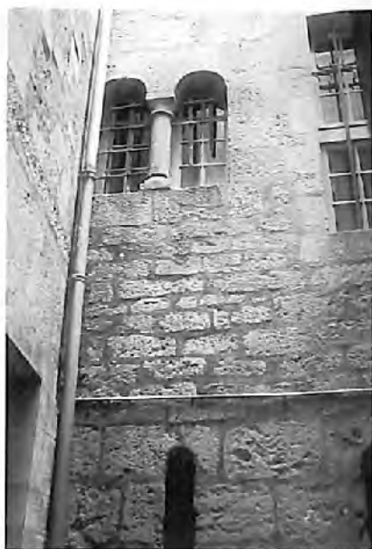
Fig. 11 : Périgueux, maison 2, rue de la Nation. Façade latérale nord sur une courette ; le rez-de-chaussée n'est percé que d'une fente d'éclairage ; à l'étage, une des rares fenêtres géminées romanes conservées à Périgueux.
