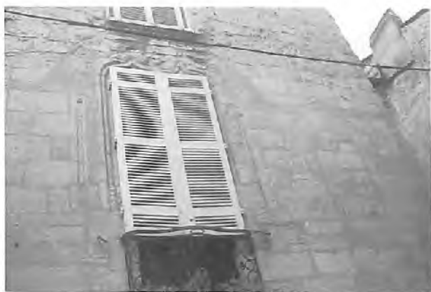
Fig. 9 : Périgueux, hôtel de Méredieu. Détail du premier étage ; la fenêtre était à plusieurs baies, entre des cordons et une archivolte bûchées ; piédroits ornés de moulures formant colonnettes ; à droite, porte qui descend plus bas que l'appui de la fenêtre.
