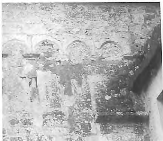
Fig. 32 : Paunat, maison du XIIe siècle dite «la Recette». Fenêtre à quatre baies, dont les colonnettes sont conservées ; les marques de l'enduit laissent deviner les fins motifs des cordons et des chapiteaux.
