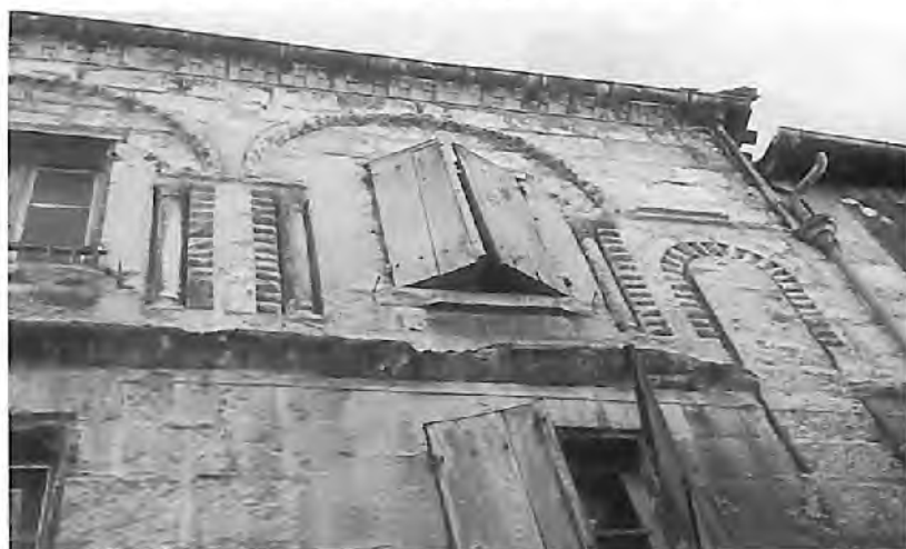
Fig. 4 : Périgueux, «maison des dames de la foi», 4-6, rue des Farges. Façade sur la rue, détail de l'angle ouest de l'étage, très décoré ; les fenêtres modernes ont pris la place de quatre baies en plein cintre ; noter la porte à droite, qui descend plus bas que le cordon d'appui.
