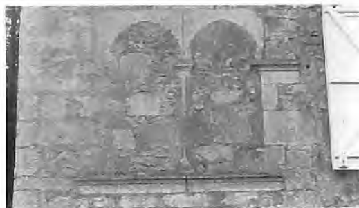
Fig.40 : Trémolat, maison du XIII e siècle, dite «la Barrière». Fenêtre géminée à deux linteaux et meneau-colonnnette ; forme de transition.
