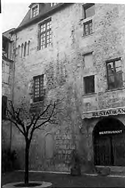
Fig. 3 : Périgueux, 10, place du Coderc (cour du passage Daumesnil). Edifice à deux étages, dont le rez-de-chaussée n'est pas percé d'arcades ; fenêtre à quatre baies au dernier niveau.
