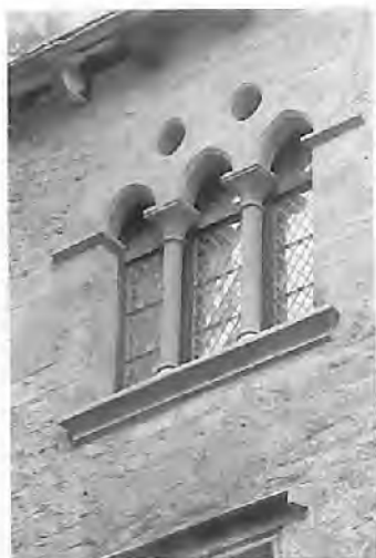
Fig. 38 : Sarlat, «hôtel Chassaing», rue des Consuls, Fenêtre triple du XIII e siècle; chaque baie est couverte d'un linteau ; deux oculi les surmontent ; noter les chanfreins et les chapiteaux lisses, en forme de calice, de cette fenêtre de transition.
