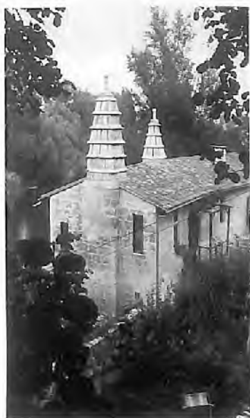
Fig. 29 : Coulounieix, maisons du XIII e siècle, dites «hôpital Charroux». Les vestiges les plus notables sont les originales souches de cheminée ; le coffre de celle qui est au premier plan fait saillie hors du mur pignon.
