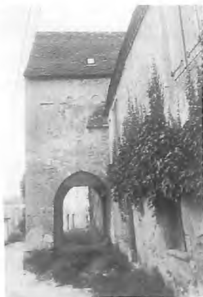
Fig. 31 : Paunat, maison du XIIe siècle, dite «la Recette», au nord de l'abbatiale. Rare exemple de maison romane avec avant-corps sur arcades brisées qui s'achèvent par des plinthes ; au premier étage de la façade nord, une fenêtre à quatre baies.
