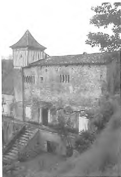
Fig. 23 : Bigaroque, maison du XIIe siècle, près de l'église. Aucun percement roman n'est discernable au rez-de-chaussée, le pigeonnier est assis sur un contrefort.
