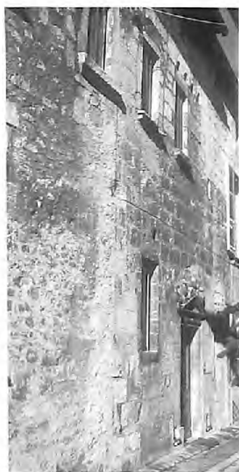
Fig. 13 : Périgueux, maison 18, rue du Plantier. Façade sur la ruelle, le rez-de-chaussée est percé de deux arcades, dont une se devine autour de la porte classique ; à l'étage, une porte en arc brisé et deux fenêtres à quatre baies.
