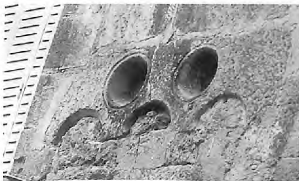
Fig. 12 : Périgueux, maison 6, rue Notre-Dame. Façade est, sur cour ; linteau d'une fenêtre triple avec deux oculi ; les arêtes des baies sont chanfreinées ; à l'intérieur, l'ébrasement de la fenêtre est peint.
