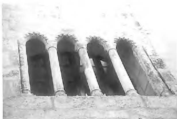
Fig. 19 : Périgueux, maison 6, rue Saint-Roch. Fenêtre à quatre baies, couverte par deux linteaux ; les colonnettes engagées et les étoiles sur l'intrados des arcs sont le seul décor ; on devine au deuxième plan l'arrière-voûture qui embrasse les quatre baies.
