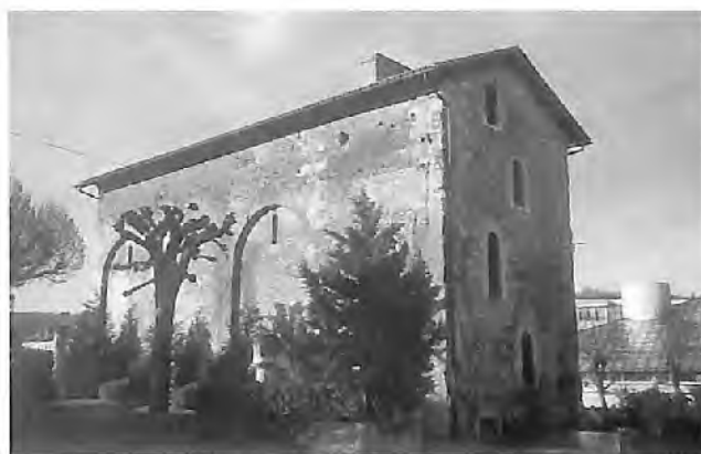
Fig. 21 : Périgueux, «hôtel d'Angoulême», dans la Cité. Hôtel noble des XIe et XIIe siècles, le logis roman à deux niveaux était complété par une tour de l'enceinte gallo-romaine, réaménagée ; les percements de la façade droite sont modernes.
