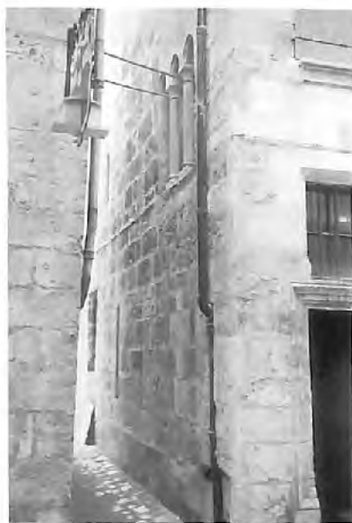
Fig. 17 : Périgueux, 10, rue de la Sagesse. Façade sur la ruelle nord ; elle est percée à l'étage d'une fenêtre triple récemment restaurée, et d'une baie simple ; au rez-de-chaussée, une fente d'éclairage.
