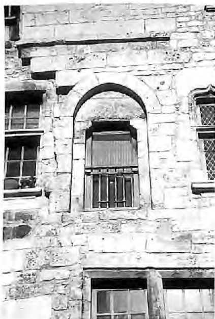
Fig. 7 : Périgueux, maison 4 bis, rue Limogeanne. Porte du deuxième étage, qui donnait accès à un balcon ou une galerie ; deux trous (bouchés), dans l'assise sous le seuil, sont sans doute les logements de poutres ; linteau droit sur coussinets profilés de plusieurs cavets.
