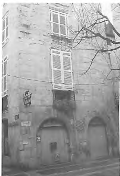
Fig. 8 : Périgueux, hôtel de Méredieu, 12, rue Limogeanne, à l'angle de la rue Lanmary. Répris aux XVe et XVIe siècles, ce grand immeuble roman contrôlait le carrefour Marsal.
