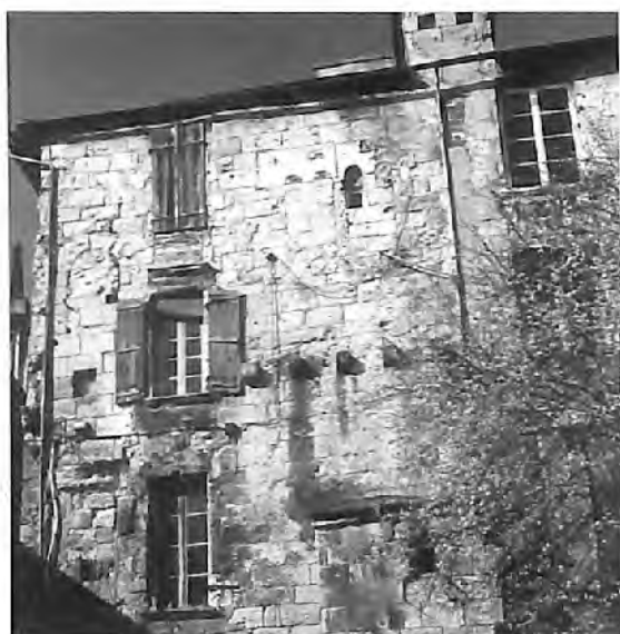
Fig. 5 : Périgueux, «maison des dames de la foi», 4-6, rue des Farges. Façade arrière, détail de l'angle ouest de l'étage, absence de décor sur la fenêtre à quatre baies ; à gauche, arc qui signale une armoire murale : file de corbeaux, supports d'une galerie dont la porte ouvrait plus à droite.
