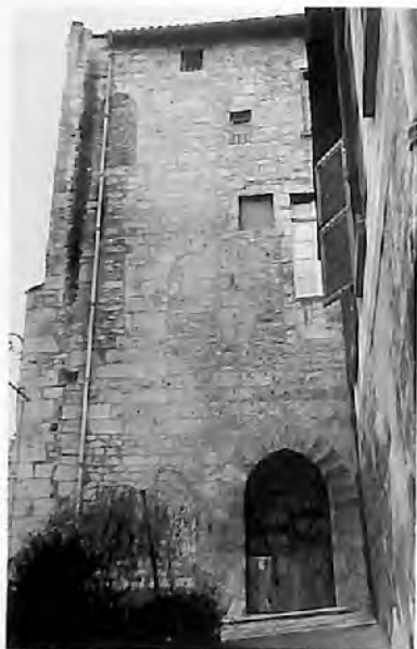
Fig. 10 : Périgueux, maison 2, rue de la Nation. Façade arrière ; trois portes superposées ; celles des étages ouvraient probablement sur des galeries en bois.
