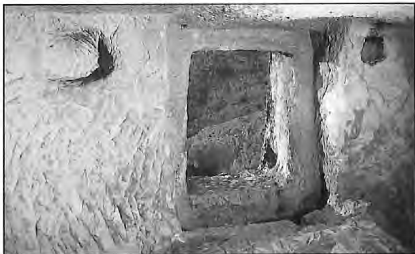
La plupart des fenêtres possèdent une feuillure qui permettait de disposer une porte de bois ; ici il existe également deux niches creusées de part et d'autre de l'ouverture (cliché J. et L. Triolet)
