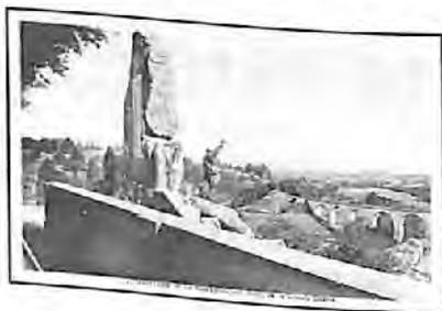
Le monument à construire se compose globalement de 4 gradins de granit, côté vallée, dominés par un énorme bloc granitique de 6 mètres de hauteur. Les attributs décoratifs, fixés sur le bloc, côté vallée, sont une croix de guerre en tôle martelée et bronzée, haute de 1,50 mètre et une épée également en tôle bronzée, haute de 2 mètres et
