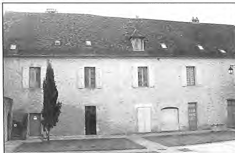
Façade nord du bâtiment situé au sud de l'enclos monastique.
