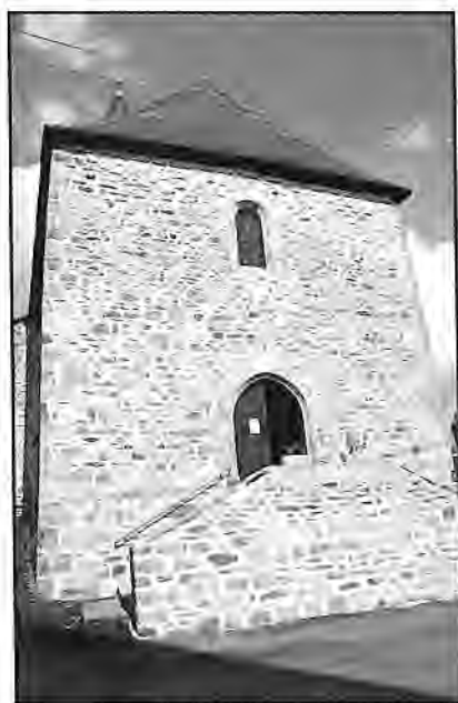
La façade ouest de l'église
