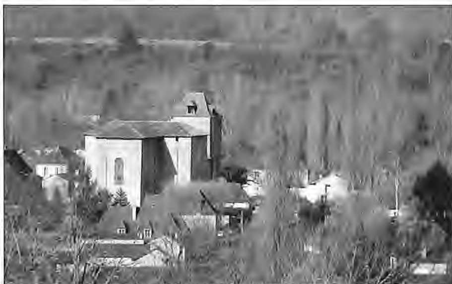
L'église de Trémolat, vue de la route de Limeuil (cliché M. Berthier).
