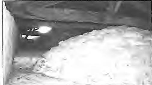
Fig. 17. Église de Cherval, charpente et extrados de coupole. Les entrails reposent directement sur les murs surélevés.
