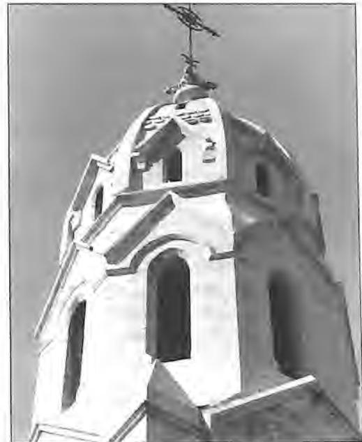
Fig. 19. Église de Bertric-Burée, clocher. La maçonnerie et la couverture de ce clocher présentent de la pierre de taille.
