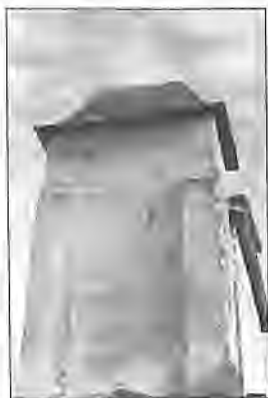
Fig. 99. Église de Siorac-de-Ribérac. Petit clocher de défense surmontant la façade fortifiée.
