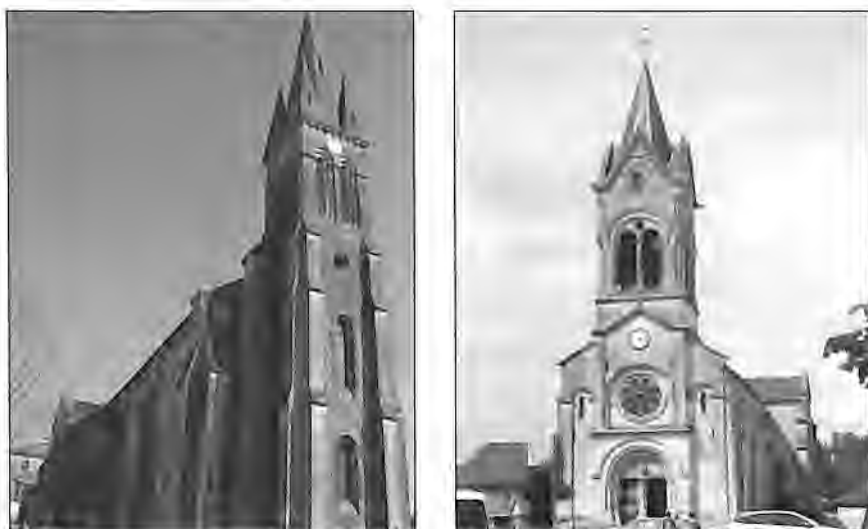
Fig. 157 et 158, Églises de Verteillac et de Tocane-Saint-Apre. Les façades illustrent parfaitement, en plein XIX e siècle, l'attrait pour le Moyen Âge.
