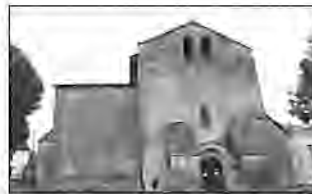
Fig. 58. Église de Saint-Just. Le clocher-mur est intégré dans un dispositif de défense.
