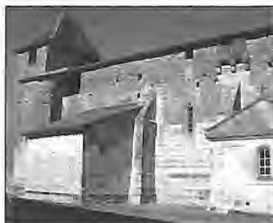
Fig. 107. Église de La Chapelle-Montabourlet, fortifications. Ouvertures de tir et bretèche participant à la défense.
