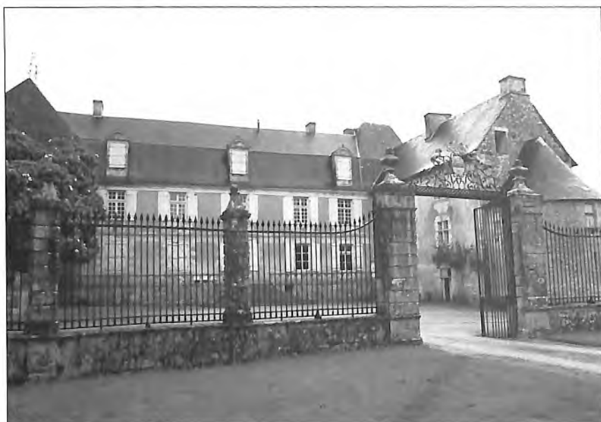
Fig. 7. Château de La Cousse à Coulaures (cliché M. Cestac).
