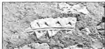
Fig. 128. Église de Tocane-Saint-Apre. Pierre sculptée romane remployée dans la maçonnerie.
