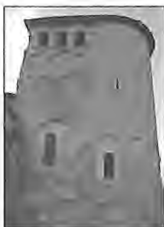
Fig. 105 et 106. Églises de Bouteilles-Saint-Sébastien et de Saint-Paul-Lizonne, chevets fortifiés. Ces édifices présentent un bahut défensif surmontant le chevet et joignant le clocher.
