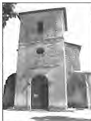
Fig. 65. Église de Parcoul. Le portail médiéval est dissimulé derrière ce clocher-porche du XIX e siècle.
