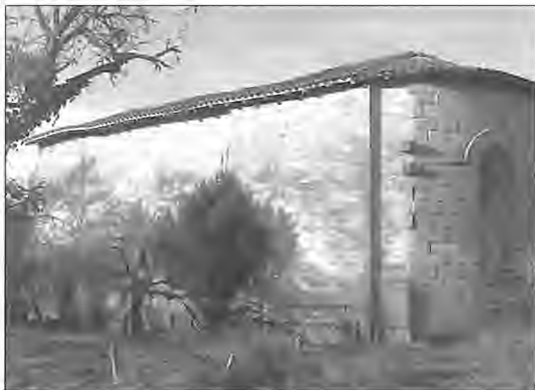
Fig. 6. Façade sud et abside de l'église du prieuré de Badeix.
