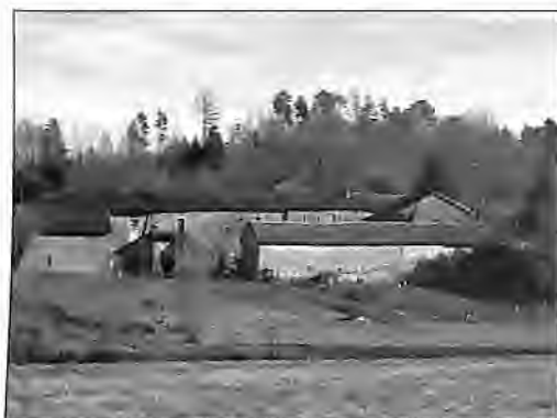
Fig. 1. Vue générale du prieuré de Badeix.
