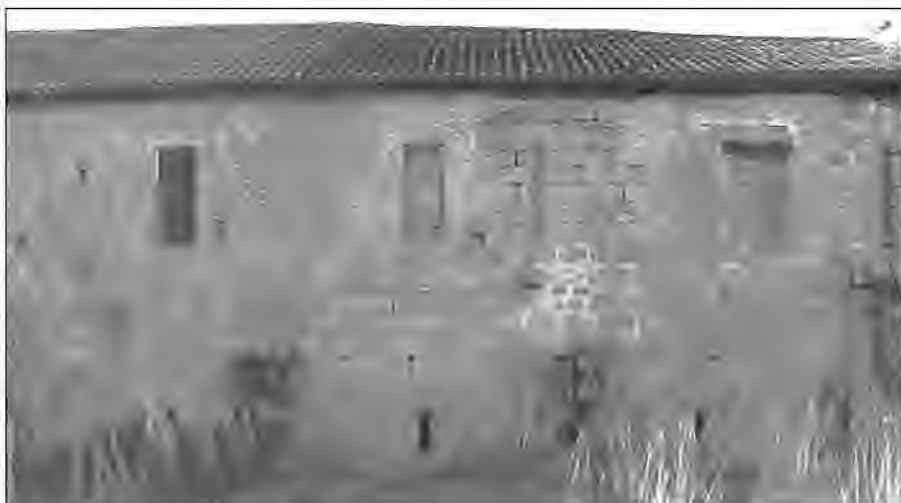
Fig. 10. Façade est de l'aile est du prieuré de Badoix. Au rez-de-chaussée, le cellier ; à l'étage, le dortoir.
