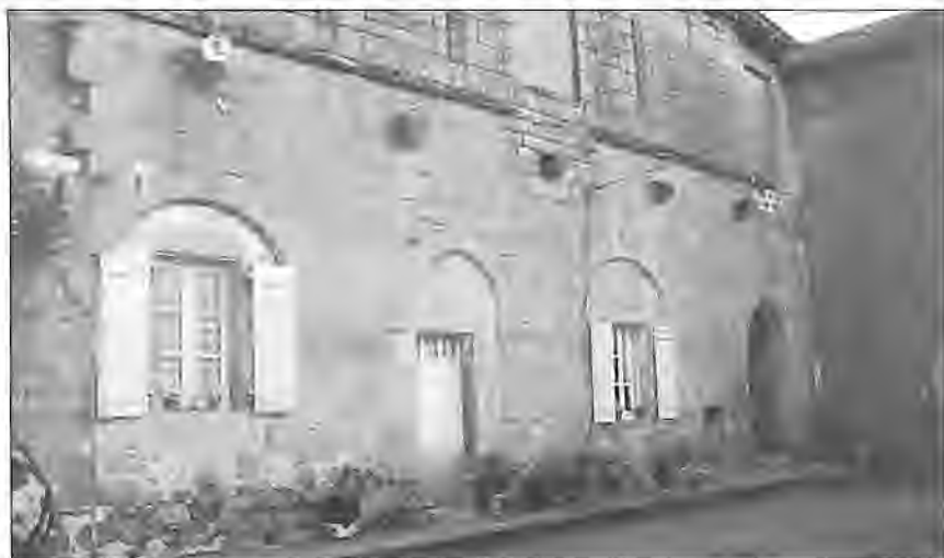
Fig. 9. Façade ouest de l'aile est du prieuré de Badeix. Au rez-de-chaussée, les trois ouvertures de la salle du chapitre, au fond la porte du passage ; à l'étage, le dortoir.
