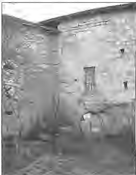
Fig. 8. Porte du passage, façade est de l'aile est du prieuré de Badeix.
