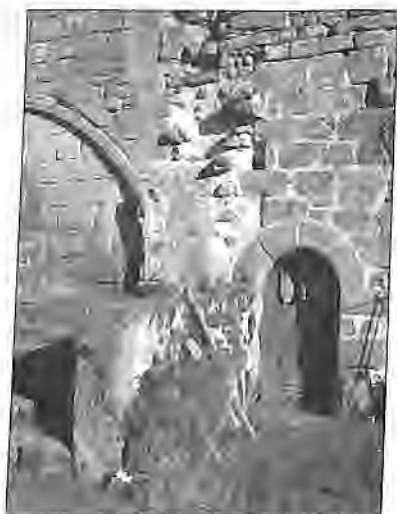
Fig. 11. Porte du cellier et traces d'arrachements de l'aile nord, façade ouest de l'aile est du prieuré de Baderix.
