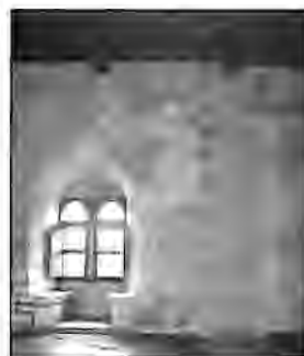
Fig. 30. Aula seigneuriale. Fenêtre à coussièges de la chambre et vestiges du mur de refend, château comtal (Bourdeilles).
