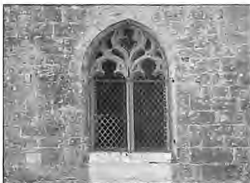
Fig. 16a. Biron, église Saint-Michel, fenêtre à remplage.
