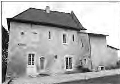
Fig. 11. Manoir de La Beauvière (Ribérac), élévation postérieure. Malgré la présence d'ouvertures récentes, l'étage noble est reconnaissable.
