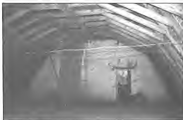
Fig. 20. Charpente à chevrons formant ferme, manoir du Logis (Chenaud).
