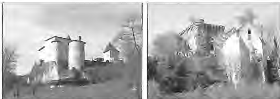
Fig. 6 et 7. Deux sites de hauteur illustrés par le château fort de Ramefort (Valeuil) et celui de Jovelle (La Tour-Blanche).
