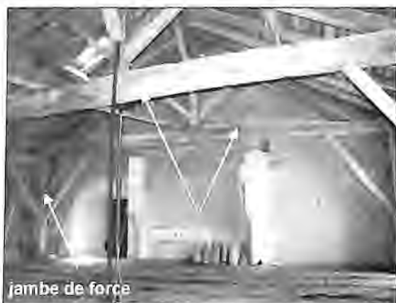
Fig. 22. Charpente d'étage de comble. La brisure de la toiture permet l'usage de pièces de bois plus petites, château de Fontenilles (Saint-Méard-de-Drôme).
