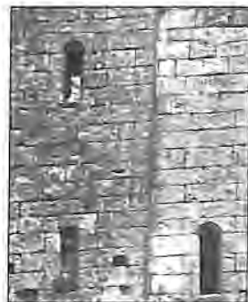
Fig. 13 et 14. La pierre de taille est utilisée pour les tours maîtresses des XII e et XIII e siècles, ainsi à Bourdeilles et La Tour-Blanche.
