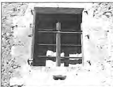
*Fig. 66. Maison forte du Port (Saint-Méard-de-Drôme), canonnière. Une petite ouverture de tir perce l'allège d'une fenêtre.*
