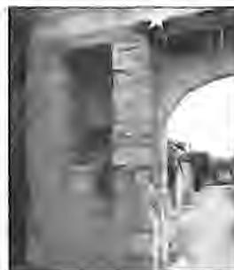
Fig. 42 et 43. Montagrier, porte de Wiridel. Cette porte de ville est le dernier témoin des fortifications d'agglomération protégeant le bourg. Elle abrite une niche à coussière et une canonnière.
