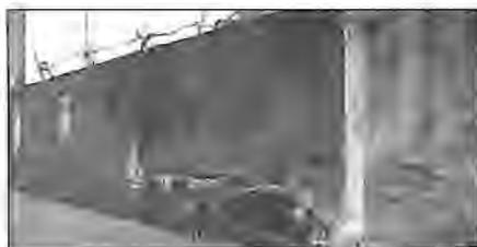
Fig. 83. Château Haut (Lisle), vestiges de type aulique. Le mur en pierre de taille ponctué de contreforts est un vestige des substructures d'une tour maîtresse ou d'une aula.
