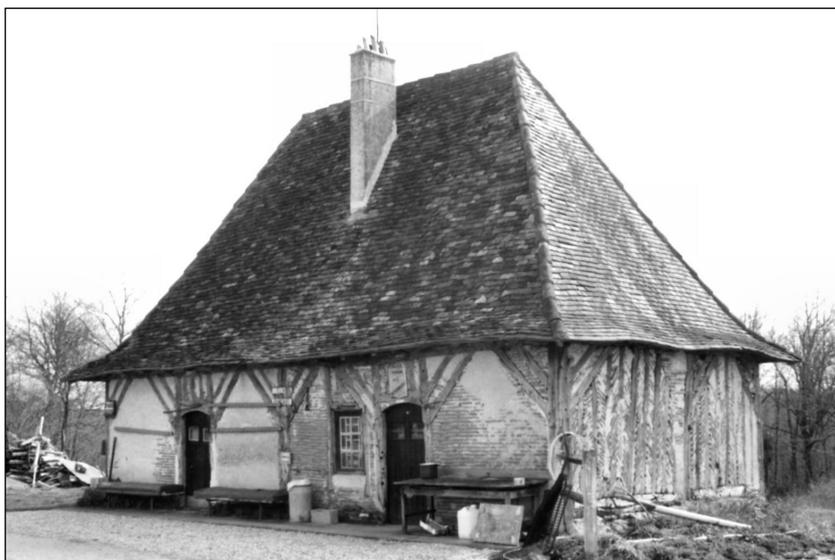
*Fig. 5. Pan de bois dans la Double. Mise en œuvre du pan de bois avec l'emploi de deux aisseliers dans les angles supérieurs. Maison des Pourcauds (Servanches).*
