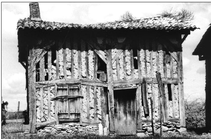
*Fig. 22. Maison élémentaire en pan de bois surmontée d'un surcroît très développé.
