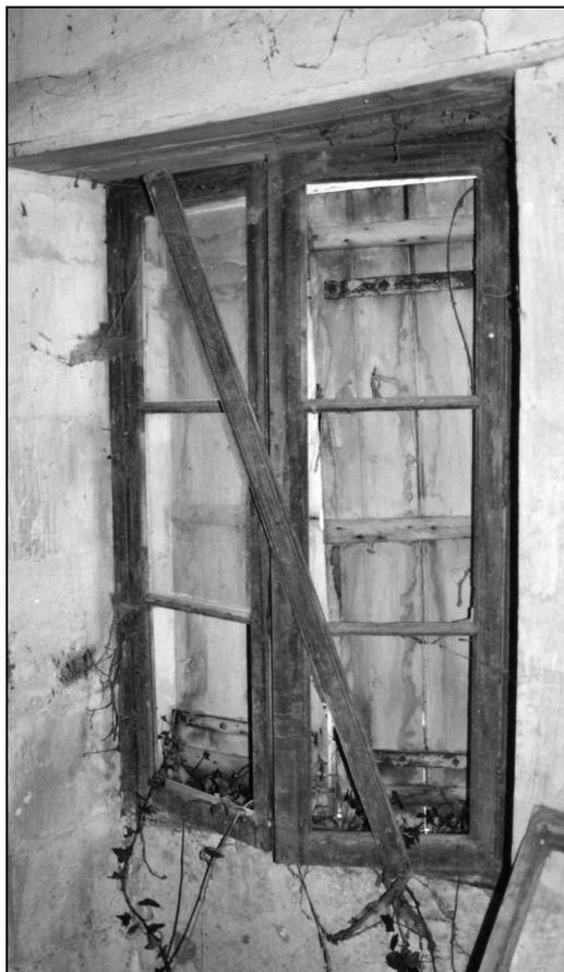
*Fig. 37. Système de fermeture de baie à fléau.
