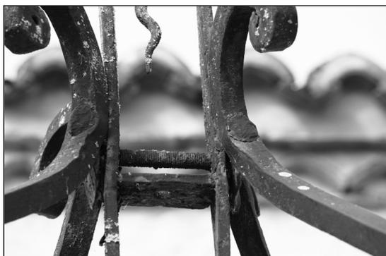
Fig. 14. Vis boulonnée serrant les plaques des volutes.
