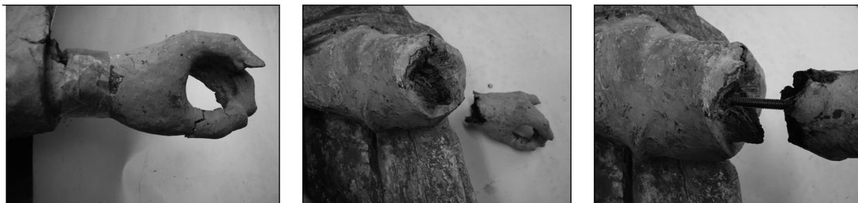
Fig. 18. Varennes, fixation de la main gauche de la statue d'Avit
