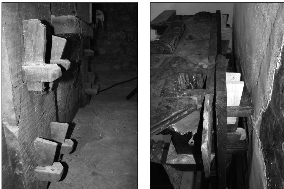
Fig. 6. Prats-de-Carlux, remplacement des taquets et clés de fixation des statues, états avant et après intervention (photos Cl. et Ch. Schmitter).
