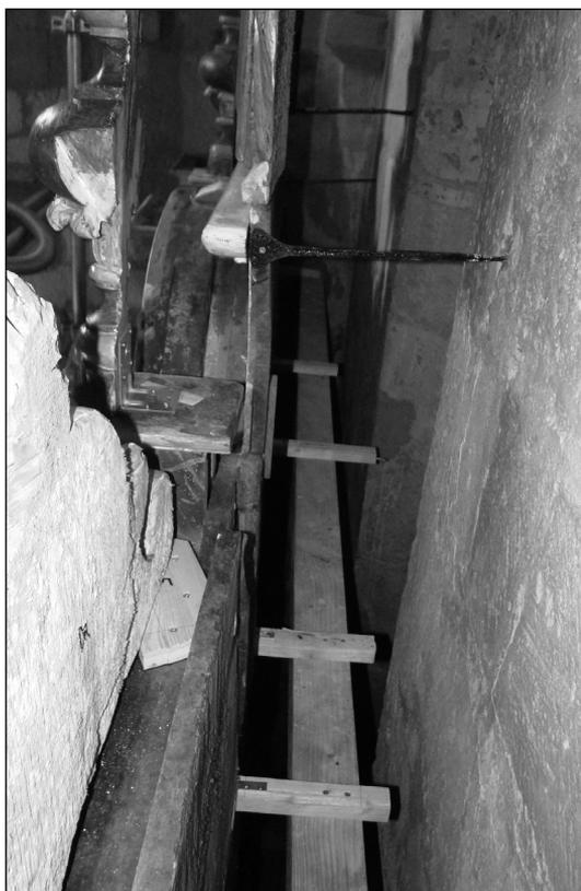
Fig. 23. Varennes, réfection du mode d'accrochage, pattes et nouvelle poutre, bitume de protection (photos Cl. et Ch. Schmitter).
