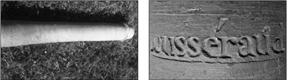
Fig. 5. Conduite de terre cuite fabriquée à Fousseyraud et marque de la fabrique « Fousseyraud » sur ce même élément (coll. X. Drago).
