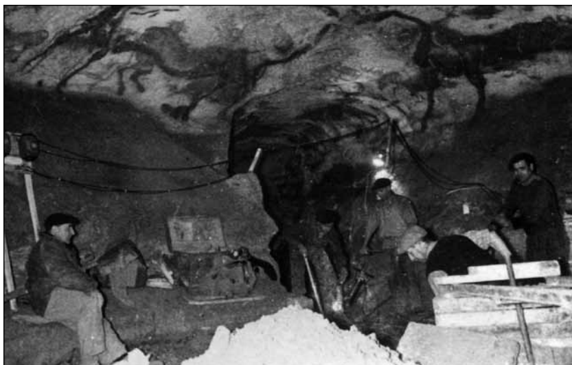
Fig. 8. Les travaux de 1957-1958. A. Glory (assis, à g.), désolé, a seulement le droit de surveiller le marteau-piqueur creusant les conduits de ventilation (cliché J. Lagrange, coll. Delluc).
