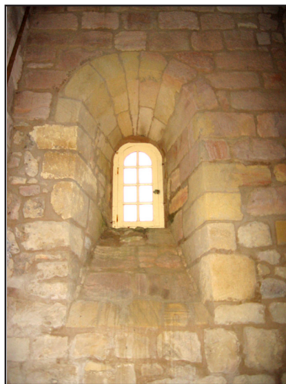
Fenêtre donnant sur une pièce du rez-de-chaussée.
