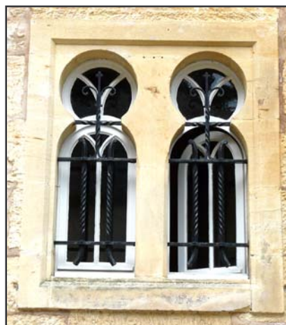
Fenêtre double sur la façade sud-ouest.
