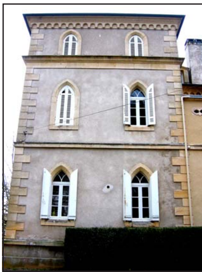
Façade nord-est aux fenêtres gothiques
