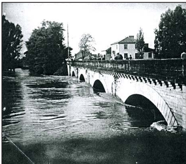
L'amont du pont sur la Vézère
