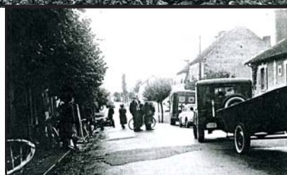
On constate les dégâts
