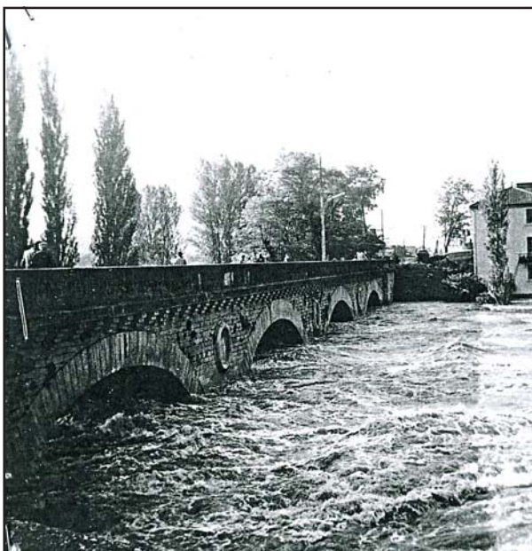
Les eaux en aval du pont
