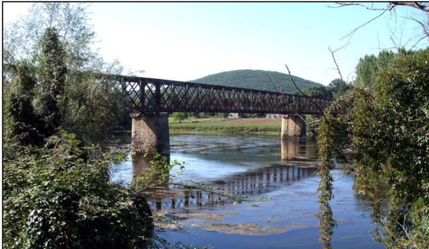
Le pont du Garrit sur la Dordogne entre Saint-Cyprien et Berbiguières
