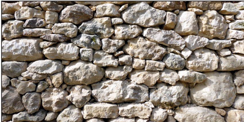
Détail d'une muraille en construction à Cadouin
