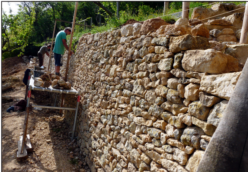
Le chantier de reconstruction d'une muraille à Cadouin
