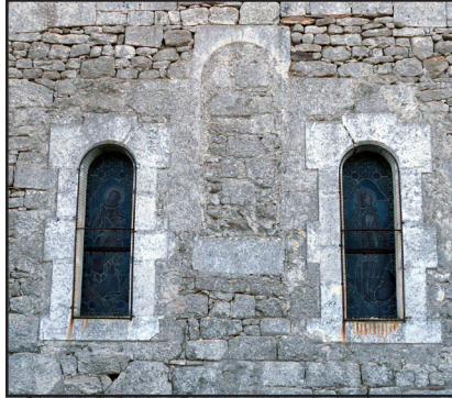
Côté nord du transept, les deux vitraux qui ont remplacé l'ouverture unique
