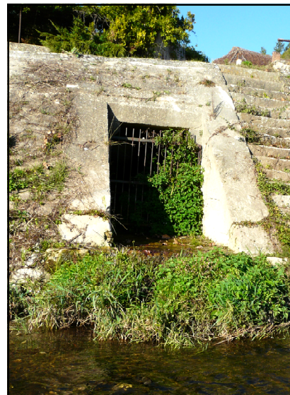
Perré et sortie de l'aqueduc
