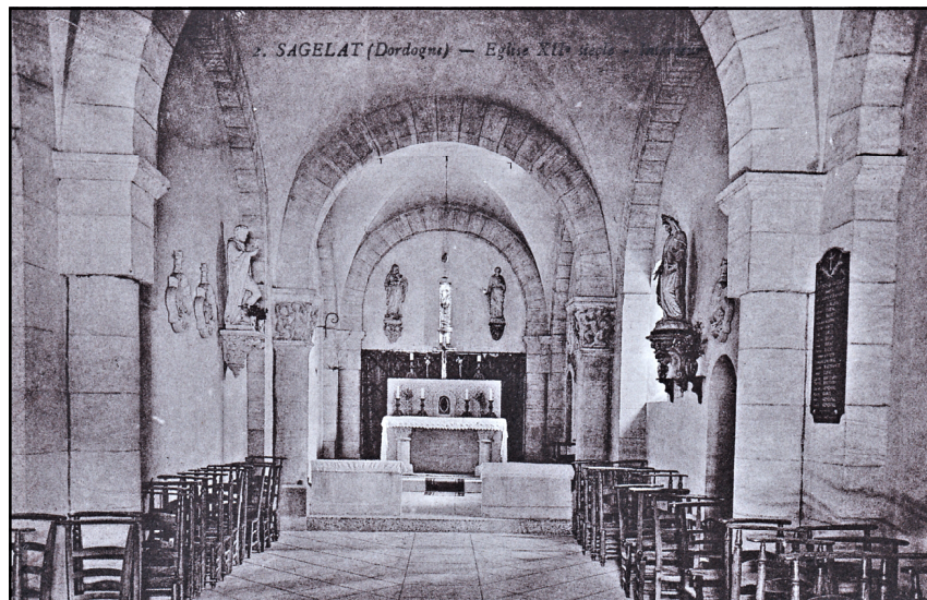
Carte postale montrant la nef après les travaux de l'abbé Chanat
