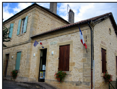
Les bâtiments scolaires de St Vincent-de-Cosse. Une partie abrite maintenant la mairie.
