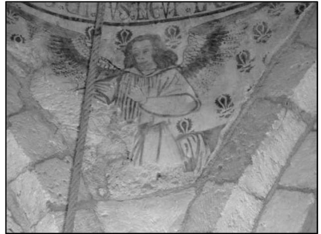
Plus rarement, les coupoles reposent sur des **trompes** ; il s'agit de l'artifice architectural qui permet de soutenir un angle saillant en encorbellement (base d'une échauguette par exemple). 23 % des coupoles d'Aquitaine reposent sur trompes, soit moins d'un quart et correspondent souvent à des coupoles octogonales (Campagne). En Italie la fréquence est beaucoup plus élevée...
