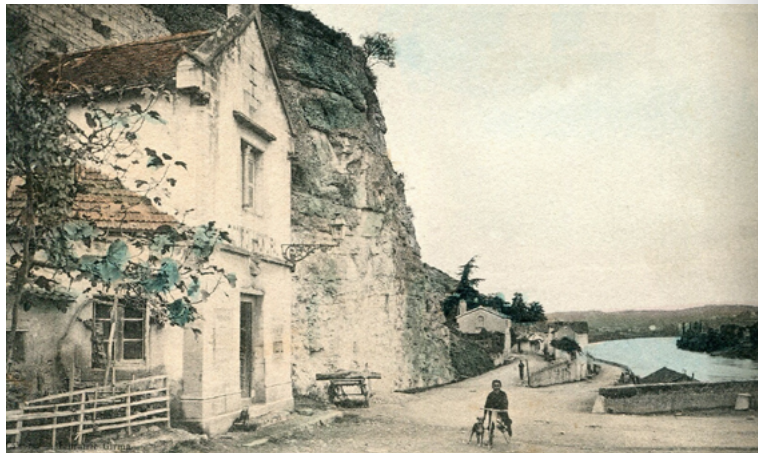
Cahors, l'octroi du Pont Valentré. Coll. J.-M. R.
