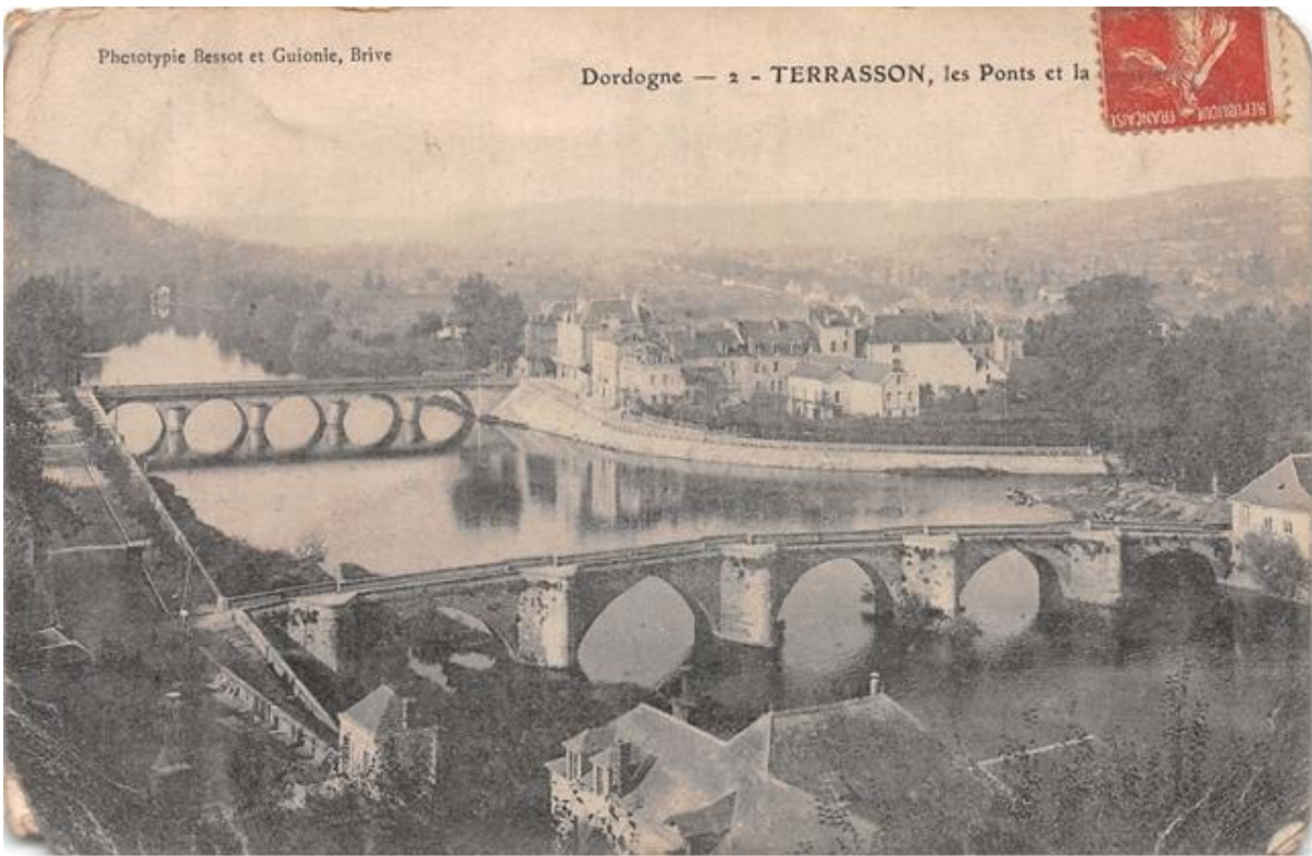
Le pont ancien de Terrasson.
