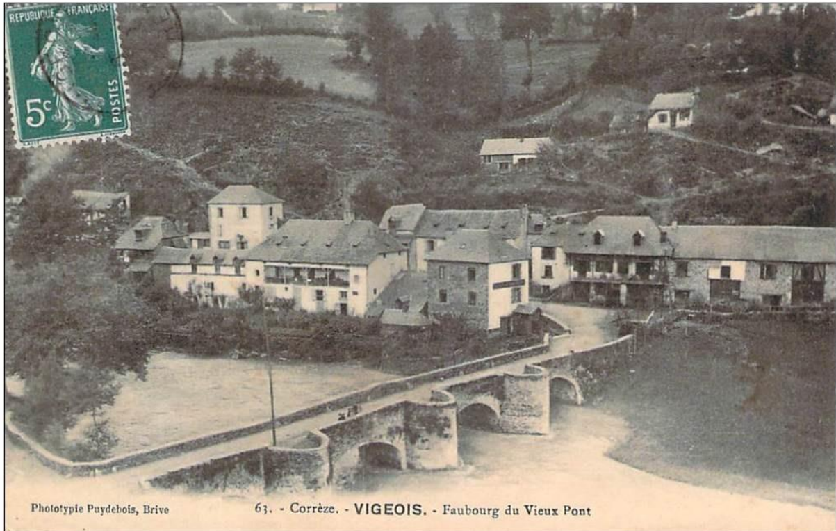
Le vieux pont de Vigeois en Corrèze
