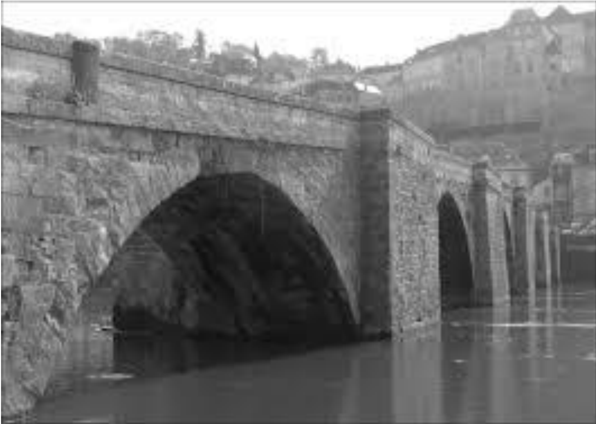
Côté aval du pont de Terrasson
