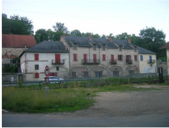
Doc 3 Bâtiments de Brardville, le Lardin.
