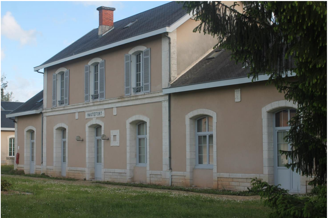
L'ancienne gare de Hautefort, transformée en bureaux pour JESCO, puis LITO, a conservé son architecture et son aspect d'origine.
