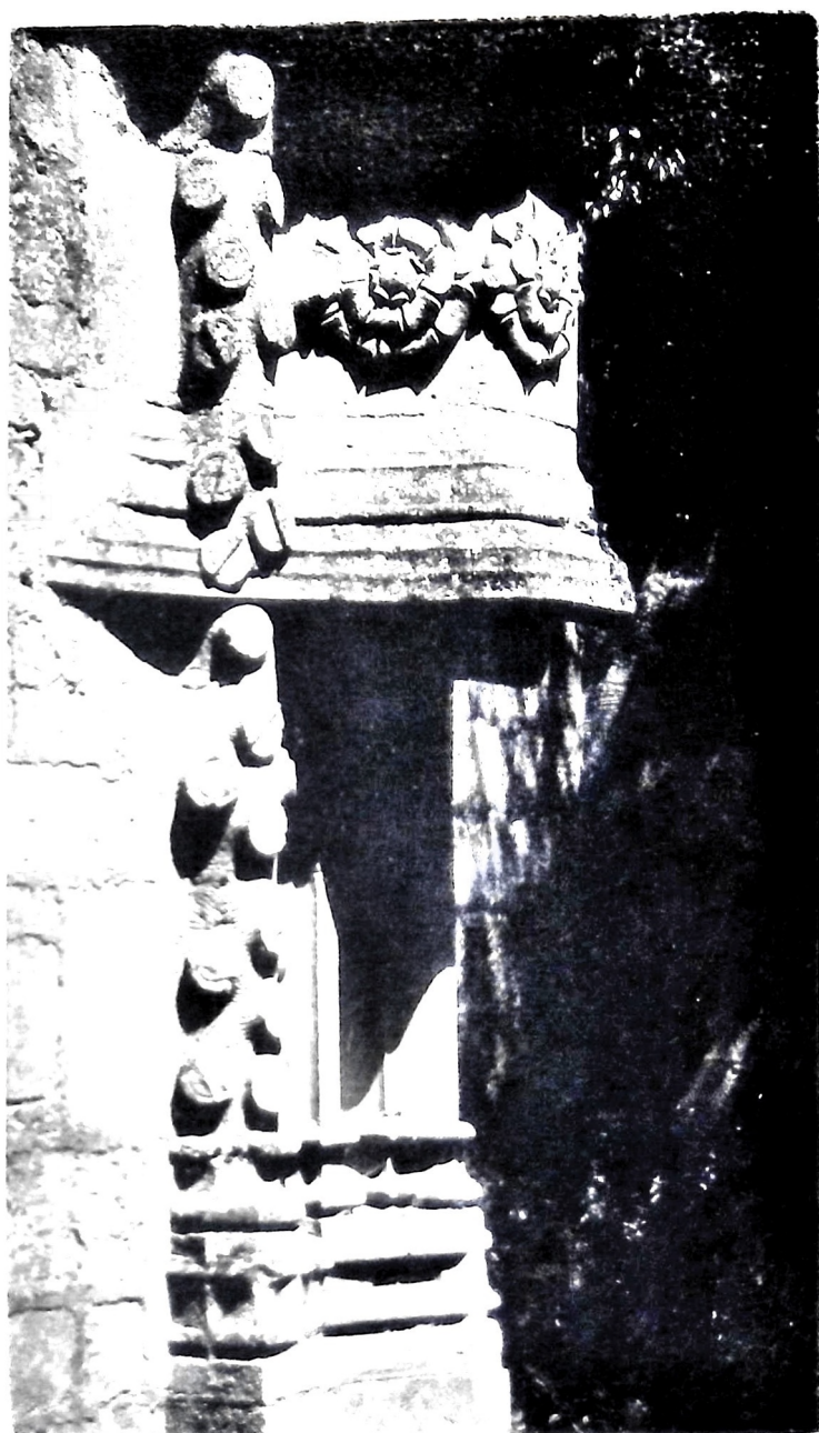
Montant de la cheminée
